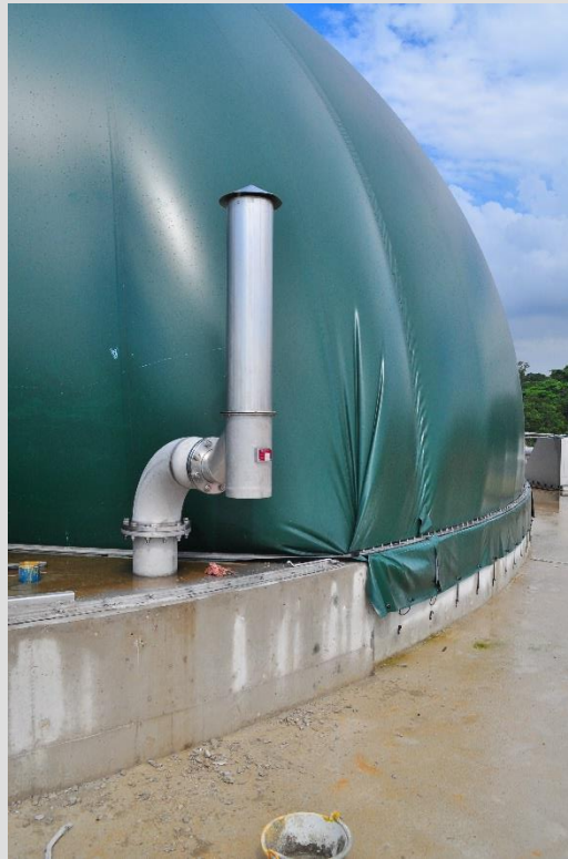
Vasche di digestione anaerobica
