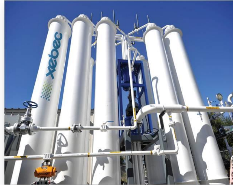
Escondido WWTP Project
