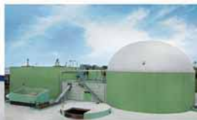
Realizzazione impianti chiavi in mano
