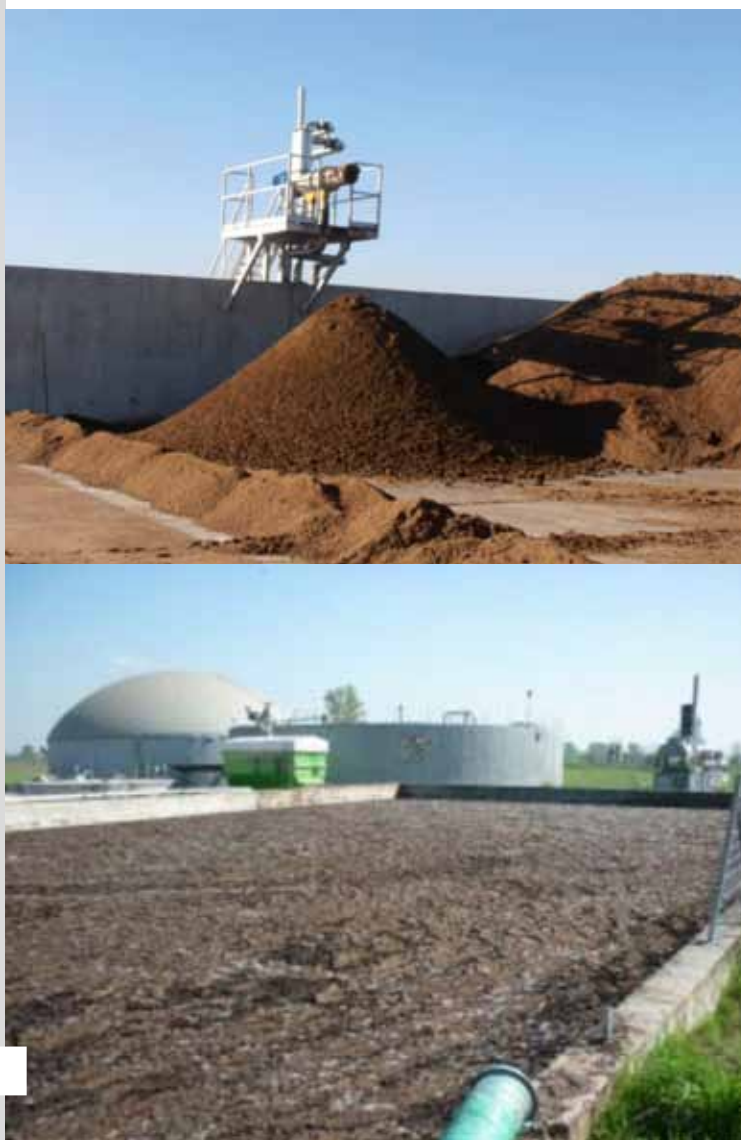
Figura 1 Esempio di separatore meccanico con cumulo di separato solido (sopra) e di vasca di stoccaggio per il digestato in uscita dall'impianto di biogas (sotto)
