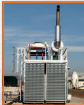
Come noto la cogenerazione prevede l'utilizzo di macchine endotermiche per la produzione combinata di energia elettrica e calore, avendo a disposizione un'unica fonte di energia primaria quale ad esempio il combustibile gassoso (gas naturale, biogas, gas da discarica, gas di torcia ecc.).
