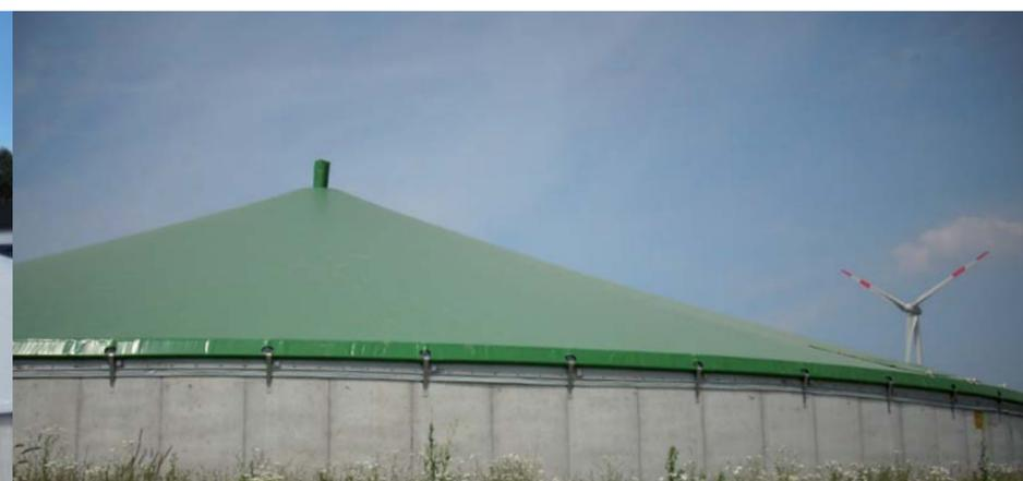
La combinazione tra accumulatore di gas e copertura a monoguscio offre un ottimale volume di accumulo a ridottissimi costi complessivi.
