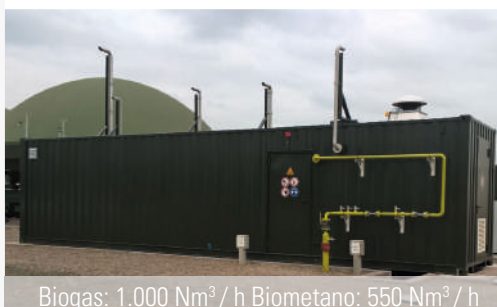
Biogas: 1.000 Nm 3 / h Biometano: 620 Nm 3 / h
