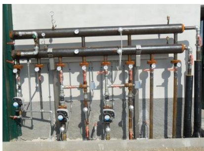
Tubazioni fluidiche per l'alimentazione con acqua calda cogenerata a servizio dell'impianto di Riscaldamento dei Fermentatori.
