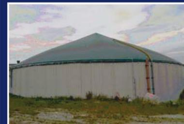
Cupola gasometrica di accumulo biogas
