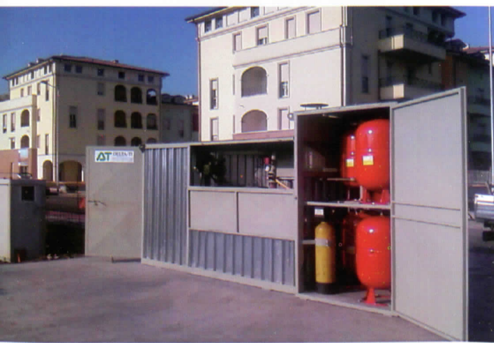
Teleriscaldamento-centrale da 1 MW
