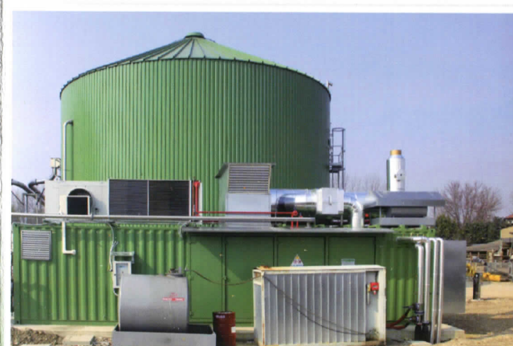
centrale mobile per avviamento impianti biogas
