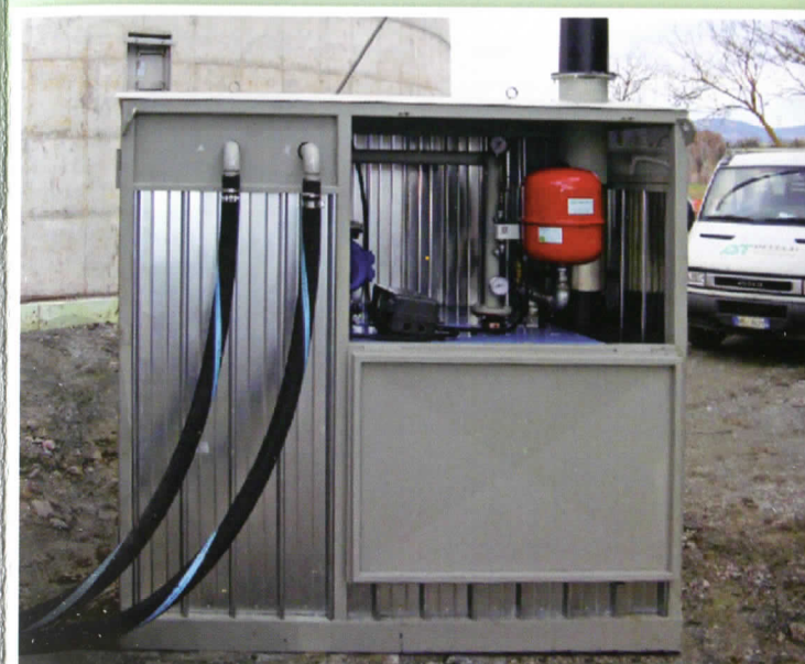
centrale mobile per avviamento impianti biogas
