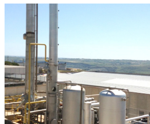
Ragusa (Italia) - Rimozione CO 2 da gas di coda impianto metano
