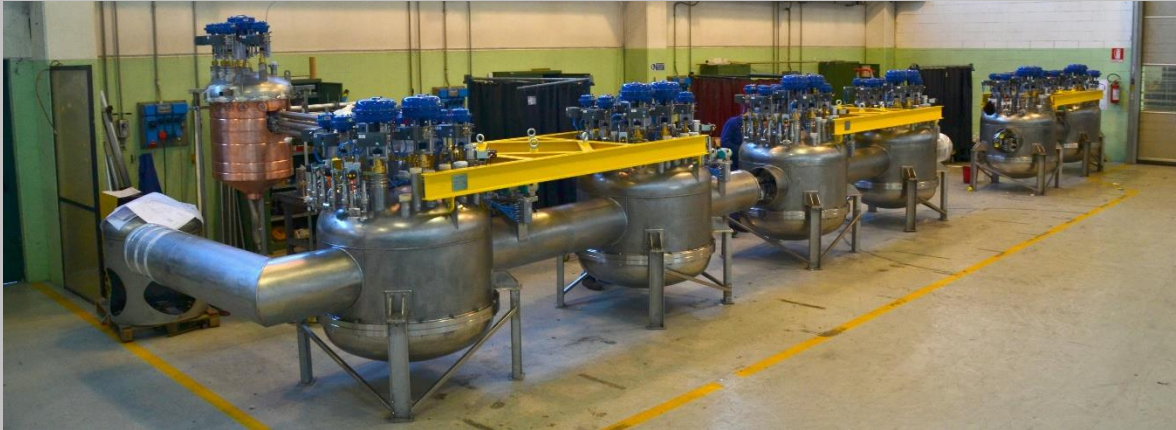
Impianto di distribuzione elio liquido per il progetto ISOLDE – CERN (Svizzera)
