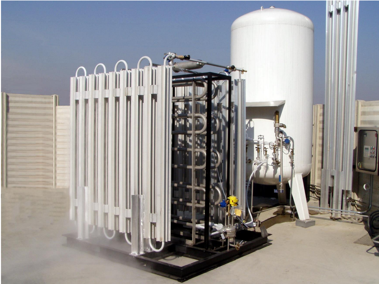
Impianto di condensazione metano utilizzando azoto liquido – Air Liquide
