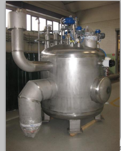
Impianto di distribuzione elio liquido per HFM e Cluster D (SM18) – CERN (Svizzera)
