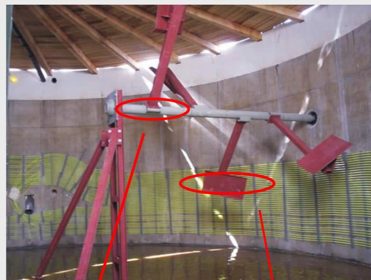
Ancoraggio puntuale con elevato sforzo durante l'immersione
