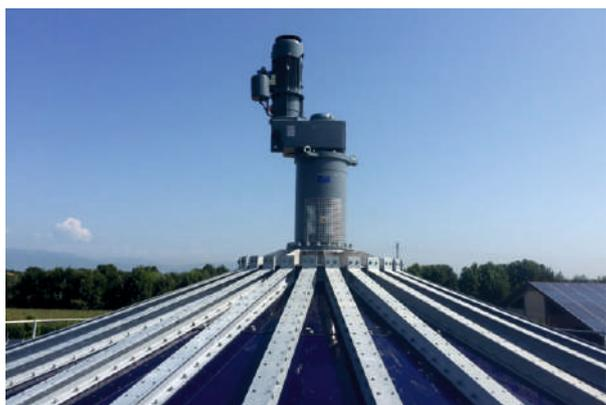
*Particolare motore e riduttore dell'agitatore*
