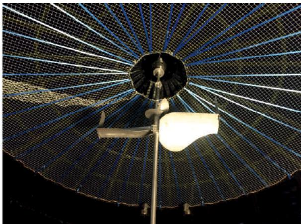
*Particolare del sistema di desolfurazione biologica e rompicrosta dell'agitatore*
