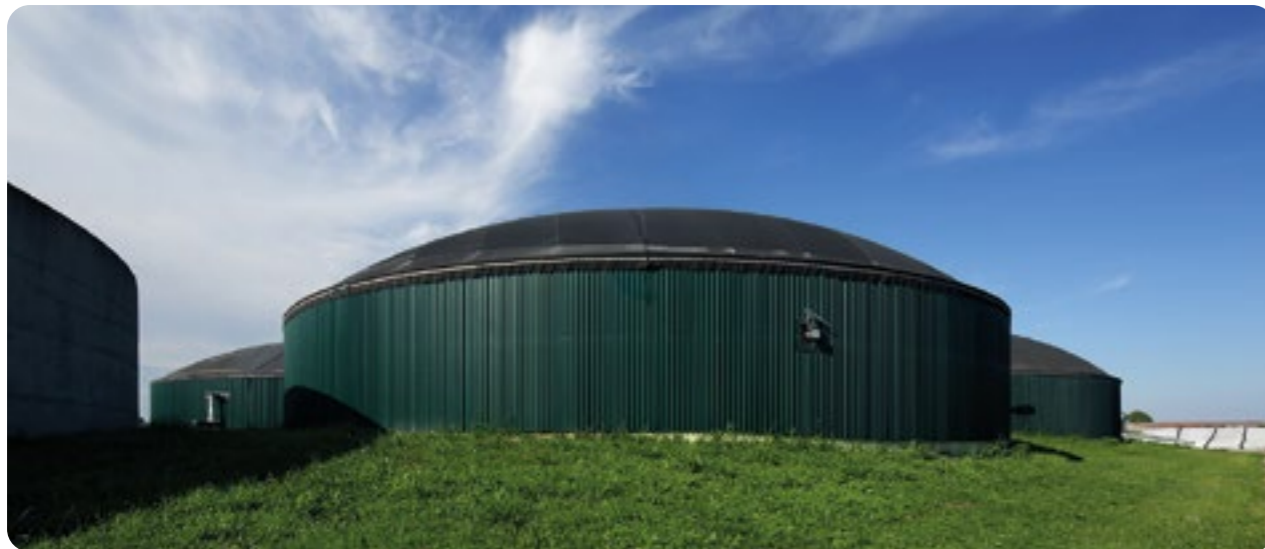
Figura 2: Impianto biogas di Ca' Corniani Figure 2: Ca' Corniani biogas plant
