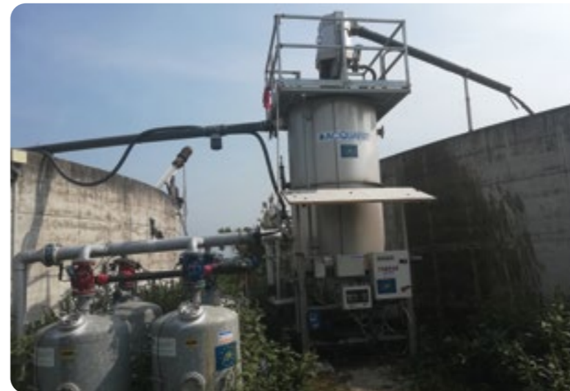
Figura 5: Impianto filtrazione del digestato utilizzato per la fertirrigazione con ala gocciolante Figure 5: Digestate filtration plant used for fertigation
