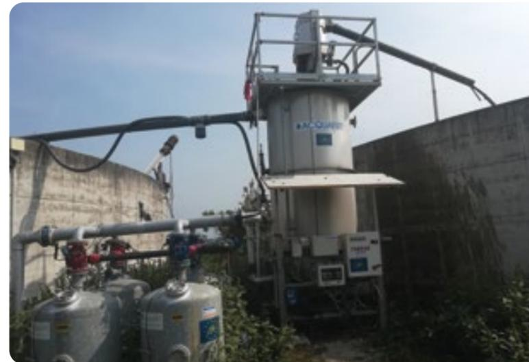
Figura 5: Impianto filtrazione del digestato utilizzato per la fertirrigazione con ala gocciolante
