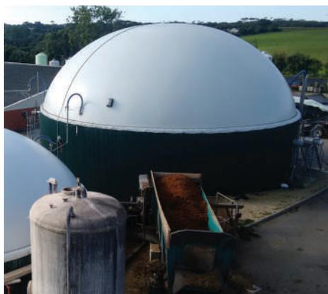
Stoccaggio del digestato con recupero del biogas
