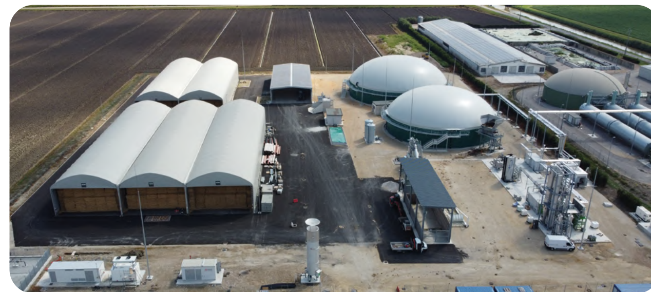
Vista dell'impianto biometano con sistema steam explosion della paglia View of biomethane plant with straw steam explosion system
