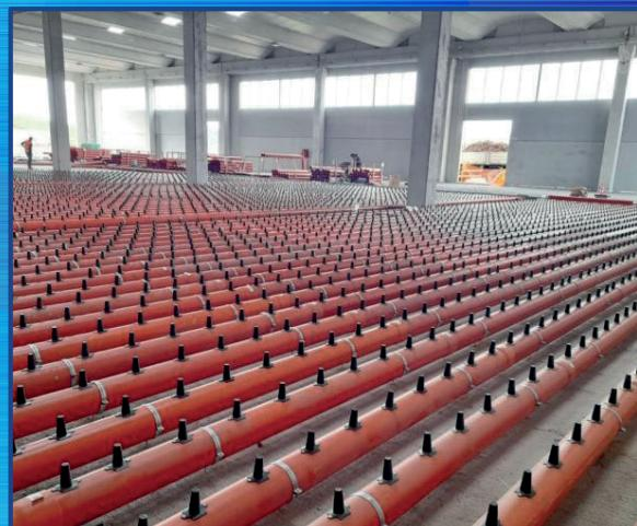
Fig.5 Esempio di installazione spigot insuflazione biocelle
