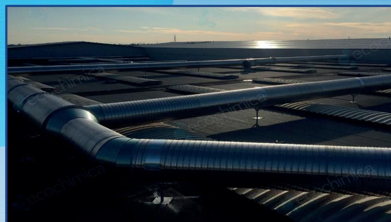
Fig.7 Sistema di canalizzazioni aerauliche di aspirazione della biocella a servizio impianto deodorizzazione
