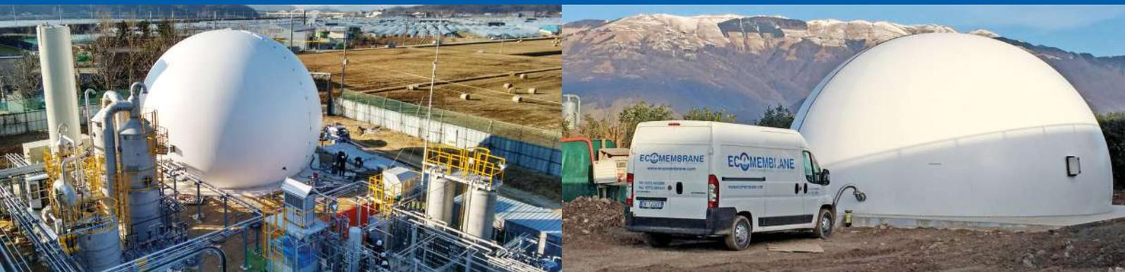
Gasometri a doppia e tripla membrana realizzate in PVC  $\frac{1}{2}$  e  $\frac{3}{4}$  sfera per grandi volumi di stoccaggio
