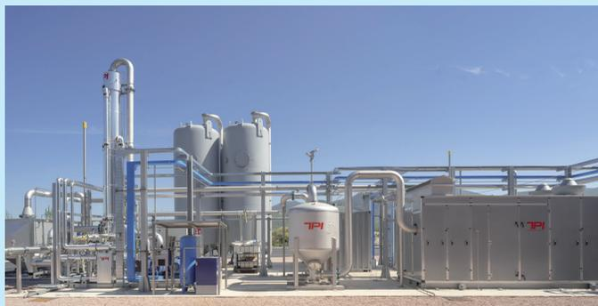
Impianto di upgrading HPSM a membrane in 3 stadi presso l'impianto Biometano di Snam 4 Environment (capitale 100% Snam S.p.A.)
