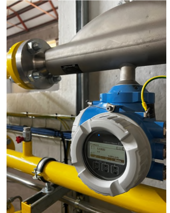
Misuratore di Portata Massico E+H. MI-002
