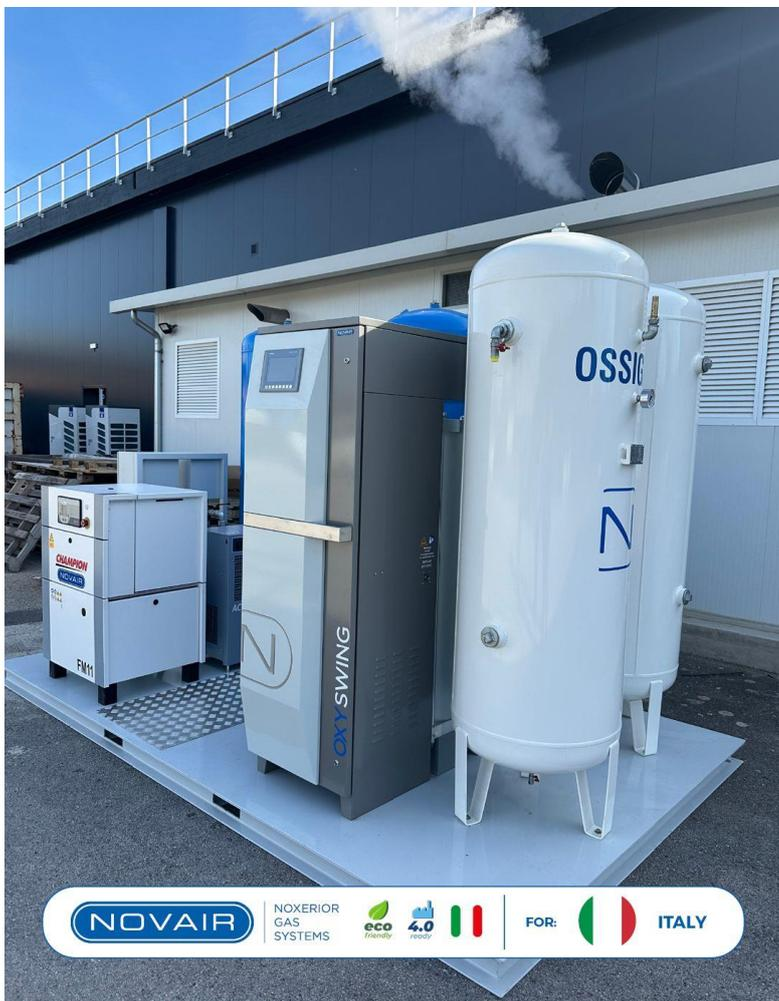
I generatori di ossigeno modulari OXY SWING® si basano sulla tecnologia Pressure Swing Adsorption (PSA) unica e brevettata. Sono dotati di moduli multipli, contenenti del setaccio molecolare, ognuno dei quali implementa un processo PSA ottimizzato e brevettato, che fornisce ossigeno di alta qualità a qualsiasi tipo di impianto Biogas per rimozione H<sub>2</sub>S.
