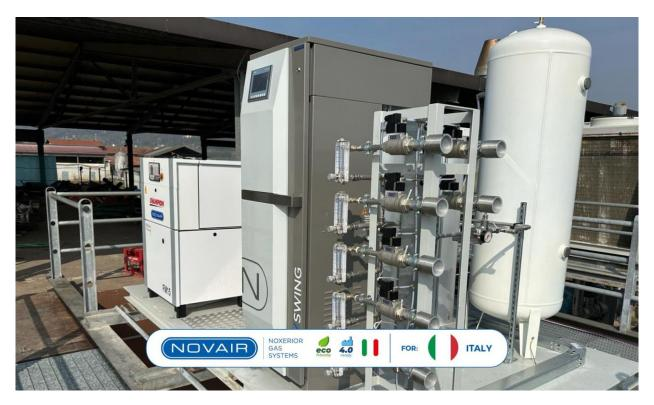
I generatori di ossigeno modulari OXYSWING® si basano sulla tecnologia Pressure Swing Adsorption (PSA) unica e brevettata. Sono dotati di moduli multipli, contenenti del setaccio molecolare, ognuno dei quali implementa un processo PSA ottimizzato e brevettato, che fornisce ossigeno di alta qualità a qualsiasi tipo di impianto Biogas per rimozione H2S.
